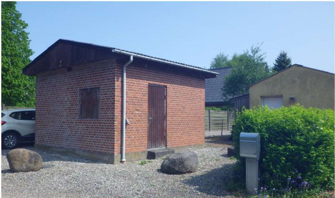
Figur 2 Vandværksbygning med vandbehandling og udpumpning
